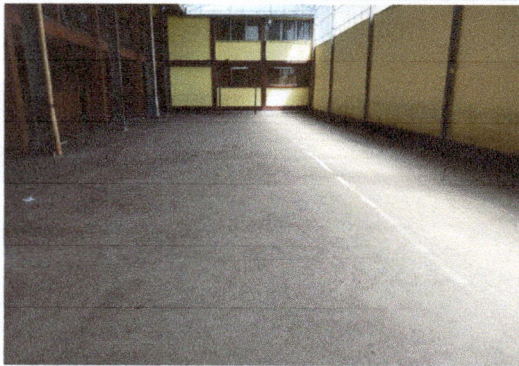
Foto 3: Losa de patio
