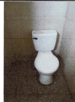
Foto 6: Reparación de accesorios de sanitarios
