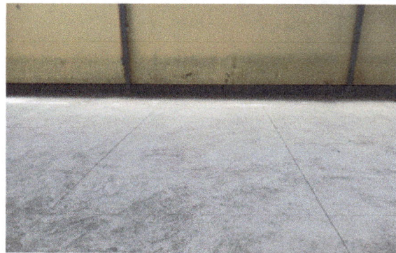
Foto 4: Losa de patio
