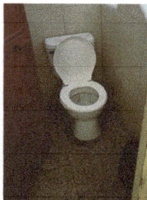
Foto 5: Reparación de sanitarios
