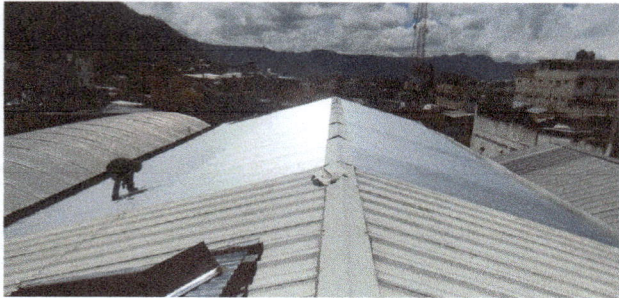
Foto 1: Cambio de lámina y capote
